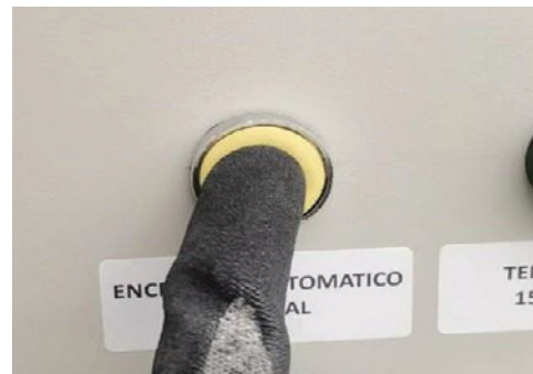
B Accionar botón de encendido automático general por 5 segundos.
